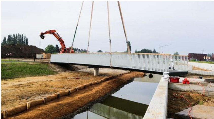
Fig. 37 – Plaatsing van een doorlopende voetgangers- en fietsbrug uit VVK (met glasvezels) te Deurne met een lengte van 20 m (2 overspanningen van 10 m) en een breedte van 2,8 m
