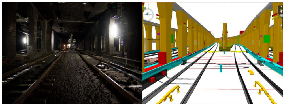
Fig. 38 – Foto van de bestaande noord-zuidspoorntunnelverbinding in Brussel (links) en zijn digital twin of 3D-BIM-model (rechts)
