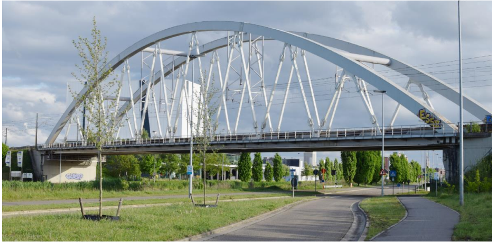
Fig. 28 – De KW51-spoorwegbrug over het kanaal Leuven-Mechelen
