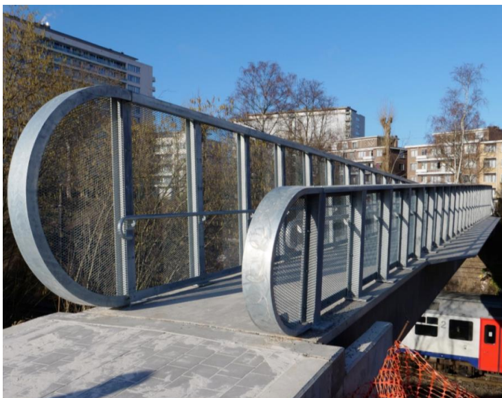
Fig. 30 – Voetgangersbrug in UHSB te Evere
