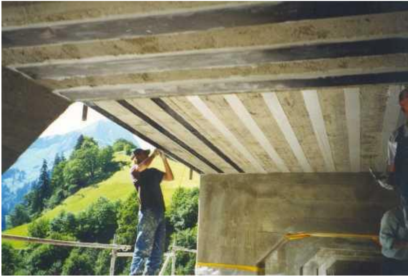
Fig. 32 - Versterking van een brugdek met koolstofcomposietlaminaten
